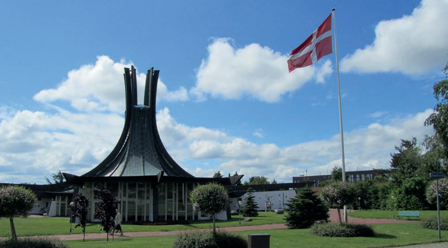
Baunekirken inden renoveringen 2010 – 2012
